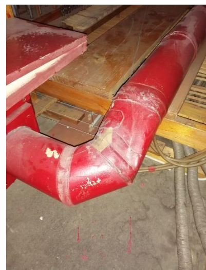
Abb. 7 Undichter Windkanal
