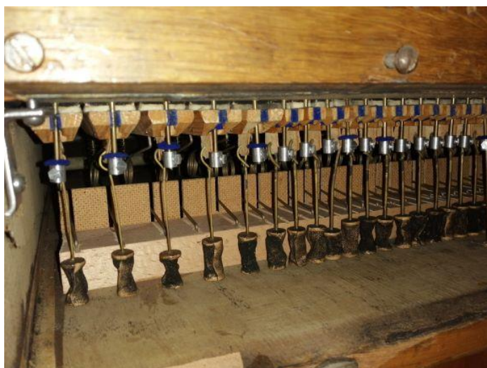
Abb. 6 Windlade I. Manual mit abgängigen Pulpeten und verformten Ventilabzugsdrähten
